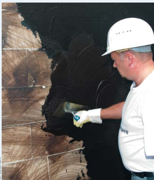
Masy bitumiczne nakłada się w kilku warstwach
