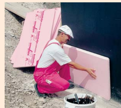
Polistyren ekstrudowany bardzo dobrze zabezpiecza ściany fundamentowe przed stratami ciepła, niestety jest drogi
