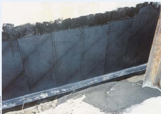
Samoprzylepna papa asfaltowa skutecznie zabezpiecza fundament przed wilgocią
