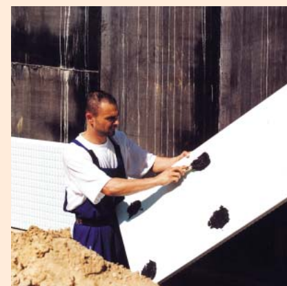
Styropian jest najtańszym materiałem termoizolacyjnym, wystarczająco dobrym również do ocieplania fundamentów
